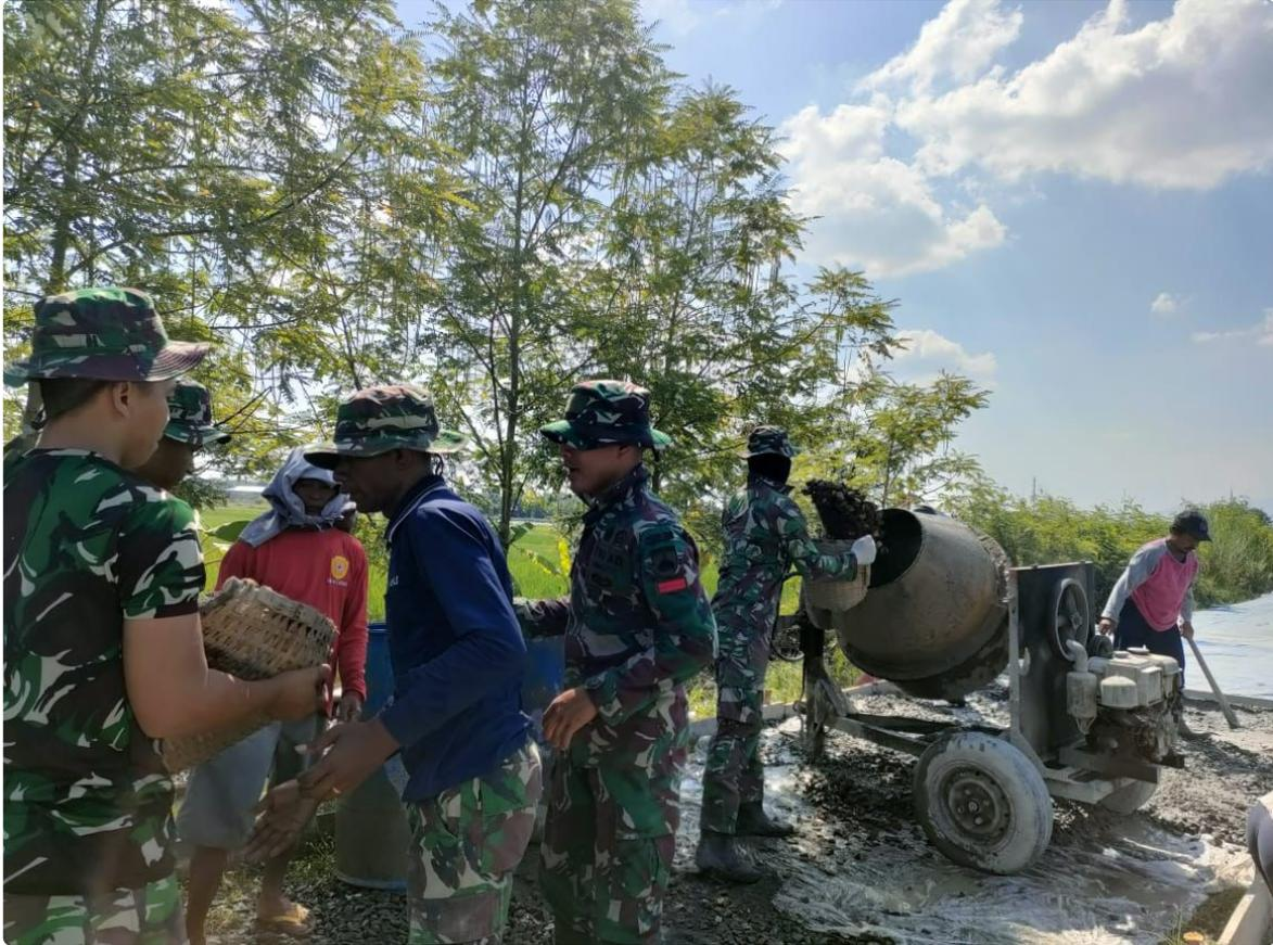
Dansatgas TMMD Reguler Ke 116 Letkol Inf Andreas Yudhi Wibowo, S.I.P., menuturkan sasaran fisik program TMMD, khususnya pengecoran Jalan Usaha Tani sepanjang 1,120 meter, lebar 3 meter dengan ketinggian 0,15 meter disebut pengerjaannya.
